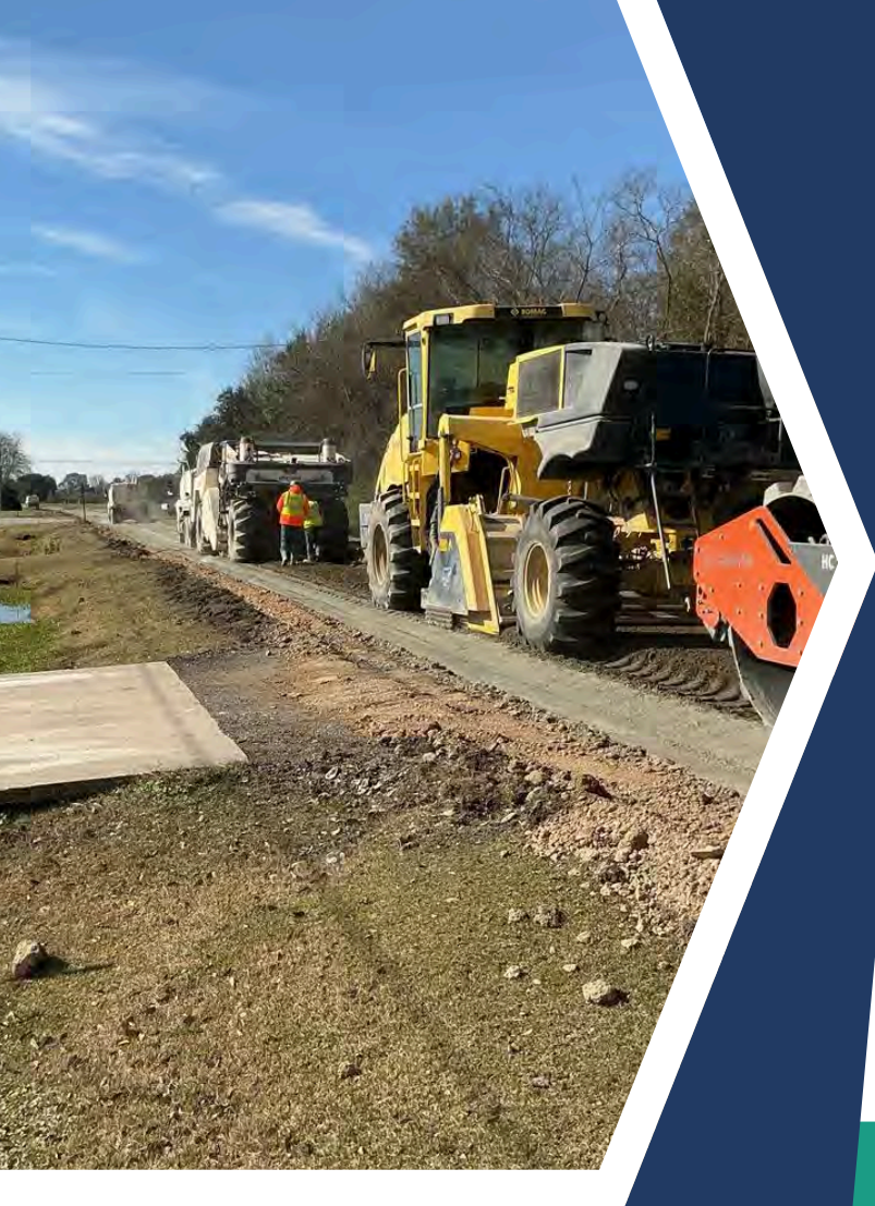
LA 95 & LA 1100 Project - Roadway Construction
